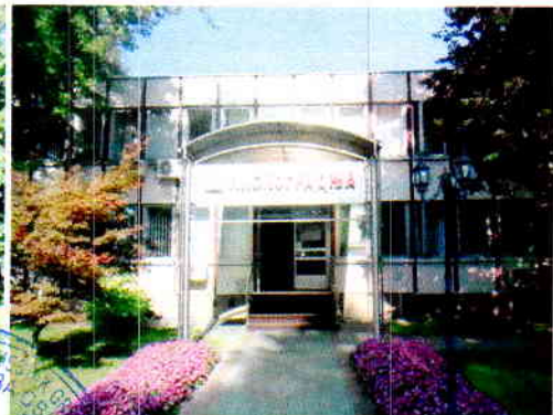
Ulaz u Upravnu zgradu NISKOGRADNJA
