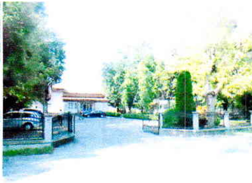
Ulaz u krug sa predmetnim objektima
