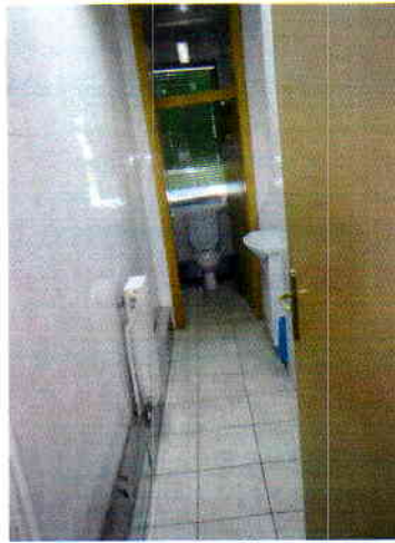
WC sa predprostorom u prizemlju upravne zgrade P+1
