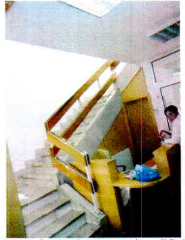
Unutrasnje stepenice u upravnoj zgradi P+1
