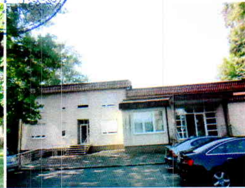
Ugostiteljski objekat Po+P+1 - ulaz u restoran
