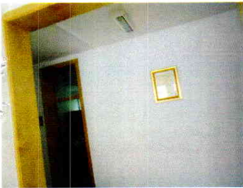
I-sprat upravne zgrade P+1 - dio unutrasnjosti
